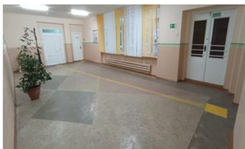
Рисунок 6 – Тактильные напольные индикаторы в помещении (направляющие и предупреждающие)
