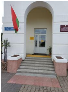
Рисунок 10- Тактильная полоса перед началом лестницы управления по труду ,занятости и социальной защите
