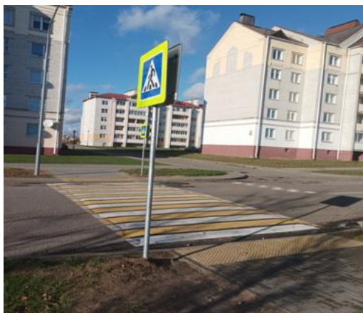
Рисунок 13- Пешеходный переход по ул. Цагельник г.Свислочь
