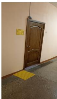
Рисунок 7 – Расширен дверной проем, установлены тактильная мнемосхема размещения объектов в санузле, речевой звуковой электронный информатор с дистанционным управлением размещен у входной группы в санузел
