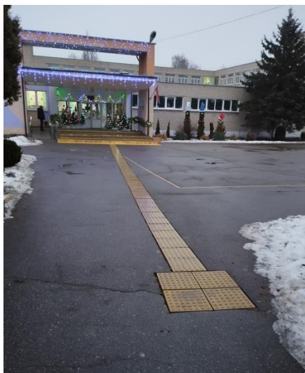
Рисунок 9 - Тактильные предупреждающие и направляющие элементы
