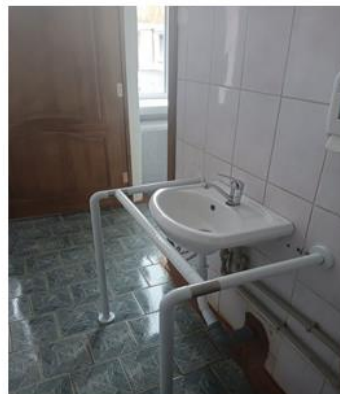
Рисунок 8 – Установлен умывальник и поручень с креплением к полу, поручни для унитаза
