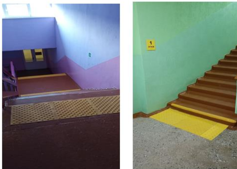
Рисунок 4 – Тактильные предупреждающие перед началом лестниц внутри здания
