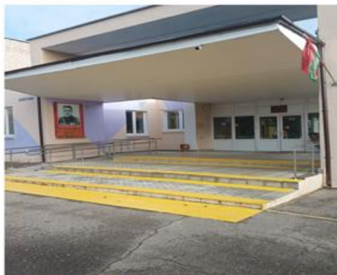
Рисунок 5 – Тактильные предупреждающие на каждой ступени при входе в здание
