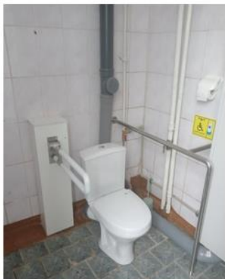
Рисунок 8 – Установлен умывальник и поручень с креплением к полу, поручни для унитаза
