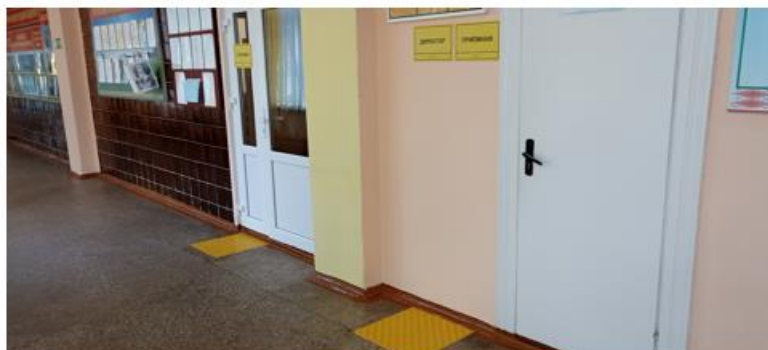
Рисунок 2 – Универсальные информационные таблички, выполненная рельефно-точечным шрифтом Брайля, для кабинетов, с предупреждающими тактильными дискретными элементами
