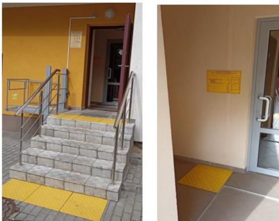
Рисунок 12 – Оборудование элементами доступной среды службы «Одно окно»
