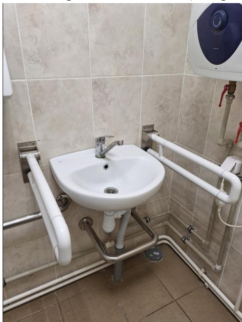
Рисунок 3 - Поручень для умывальника в санитарно-гигиенической комнате
