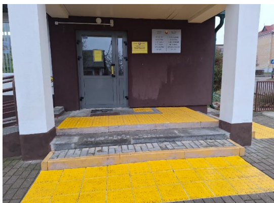
Рисунок 1 - Тактильные предупреждающие элементы перед первой и на последней ступени лестницы при входе в здание, информационная вывеска, выполненная рельефно-точечным шрифтом Брайля, контрастная маркировка на стекле входных дверей и дверной ручке, речевой информатор с дистанционным управлением.
