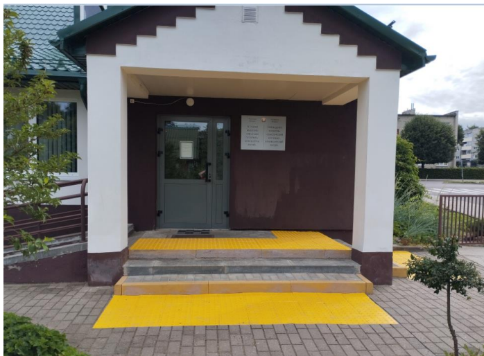
Рисунок 1 - Тактильные предупреждающие элементы перед первой и на последней ступени лестницы при входе в здание
